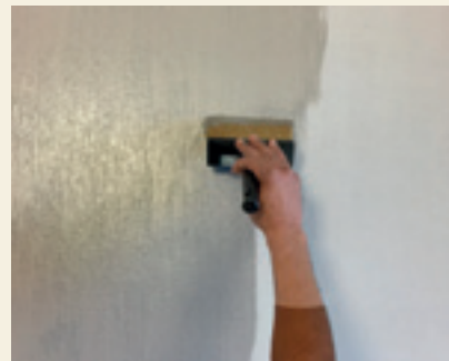
Distribuire il prodotto in parete in senso verticale per mantenere e disegnare l'effetto filante di FilidiSeta
